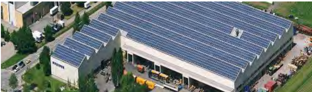
Ενσωμάτωση φωτοβολταϊκών σε βιομηχανική στέγη
